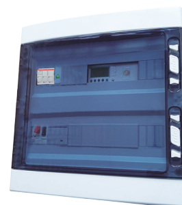
Poste de 8 mts.
